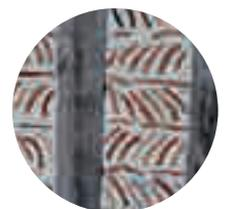
Pans de bois avec remplissage en tuiles de terre cuite maçonnées © Romain Anger / amàco
