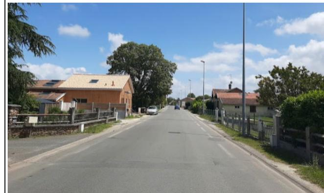
Profil à dominante routière avec une prise en charge des déplacements vélos via la mise en place d'une double bande cyclable. Les aménagements mis en place ne sont pas toujours aux normes et présentent des dimensions peu propices à un usage confortable et sûr du vélo (bandes <1.5m) .
