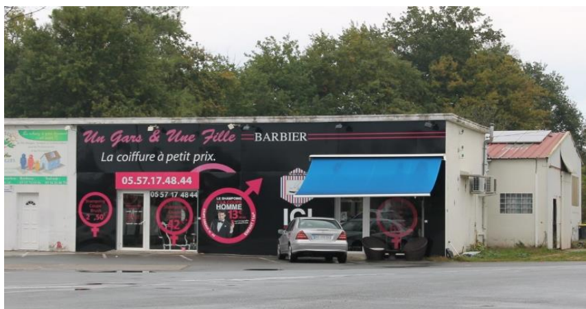
La surface cumulée des enseignes est supérieure à 25% de la façade commerciale, elles sont donc illégales.
