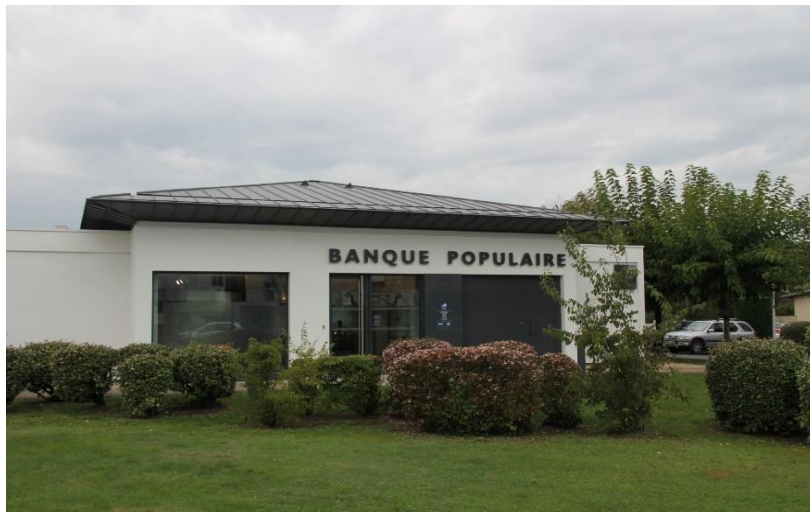
Enseignes sur façade en lettres découpées
