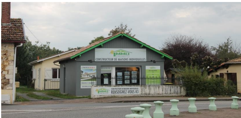
L'enseigne murale au centre, dépasse les limites de l'égout du toit. Elle est illégale
